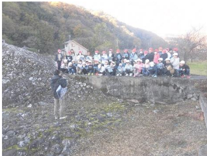
石積み出し3番堤
